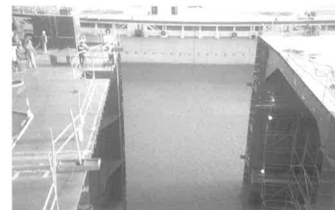
Una vez abierta la puerta del dique, se introduce el Cuerpo de Proa en éste y se amarra. Posteriormente se cierra la puerta y comienza el achique del dique. Va a comenzar la varada del Cuerpo de Popa.
