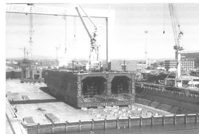
Cuerpo de Popa, listo para flotar, horas antes de la apertura de válvulas de inundación del dique.
