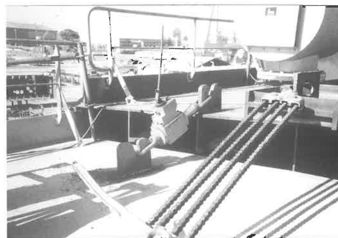
Contacto de ambos cuerpos. Tensor hidráulico de 50 toneladas, en la banda de Br.
