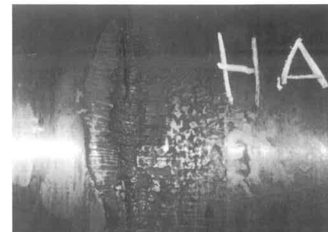
Grietas y corrosiones en un eje
