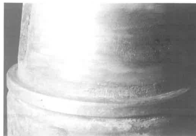
Fallo de la junta de estanqueidad y corrosiones en el eje en zona próxima al chavetero de la hélice.
