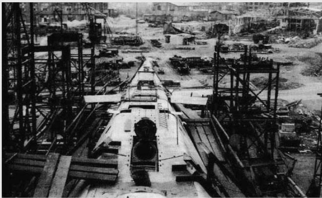
Fig. 50. Blohm & Voss después de la guerra. Aquí se ven los bloques de proa listos para montaje final
