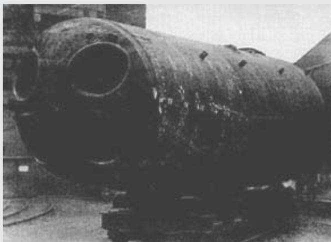
Fig. 33. Vista del bloque de proa de un buque Tipo VII C, usado para adiestramiento. Son visibles los tubos lanzatorpedos. La construcción de estas unidades en gran número por el procedimiento tradicional consumió gran número de recursos de la industria armamentística alemana
