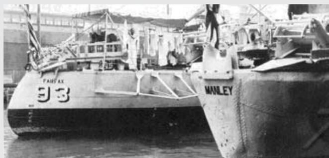
Fig. 13. Detalle de las popas del DD 93 *Fairfax* y del DD 177 *Manley*, mostrando las diferencias entre la clase precedente y la clase *flush deck*
