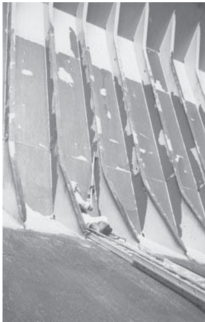
Mantenimiento de las cuadernas de las bodegas de cargas de graneros.
