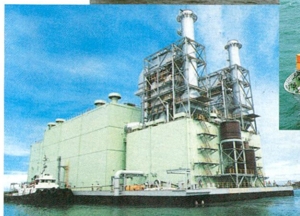
Central eléctrica flotante de dos motores diesel de dos tiempos construidos en consorcio con la empresa japonesa Mitsui, suministra 200 MW en Mindanao, Filipinas.
