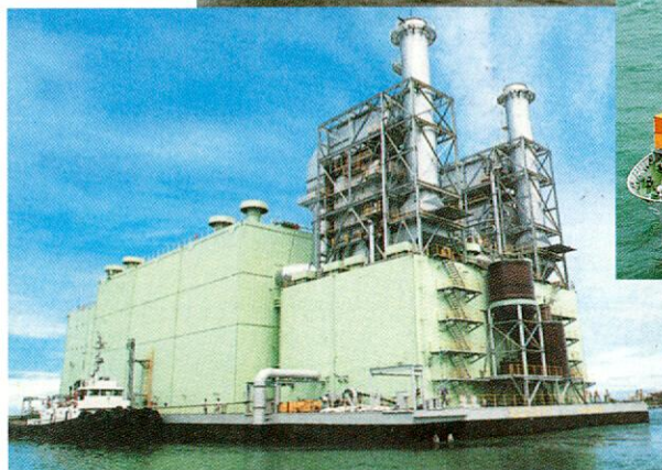
Central eléctrica flotante de dos motores diesel de dos tiempos construidos en consorcio con la empresa japonesa Mitsui, suministra 200 MW en Mindanao, Filipinas.
