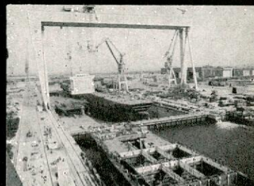
Dique de construcción de 100x525 m. y 1.200 Tons. c.e.
