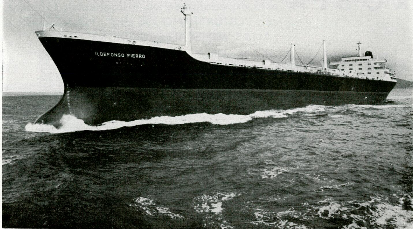
PETROLERO "ILDEFONSO FIERRO", DE LA "NAVIERA FIERRO, S. A.", DE 60.600 TONS. DE PESO MUERTO PROPULSADO POR TURBINAS DE VAPOR.
