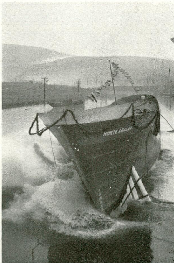
Fig. 2.—Basculando sobre los suplementos giratorios de dos metros del extremo de la imada.
