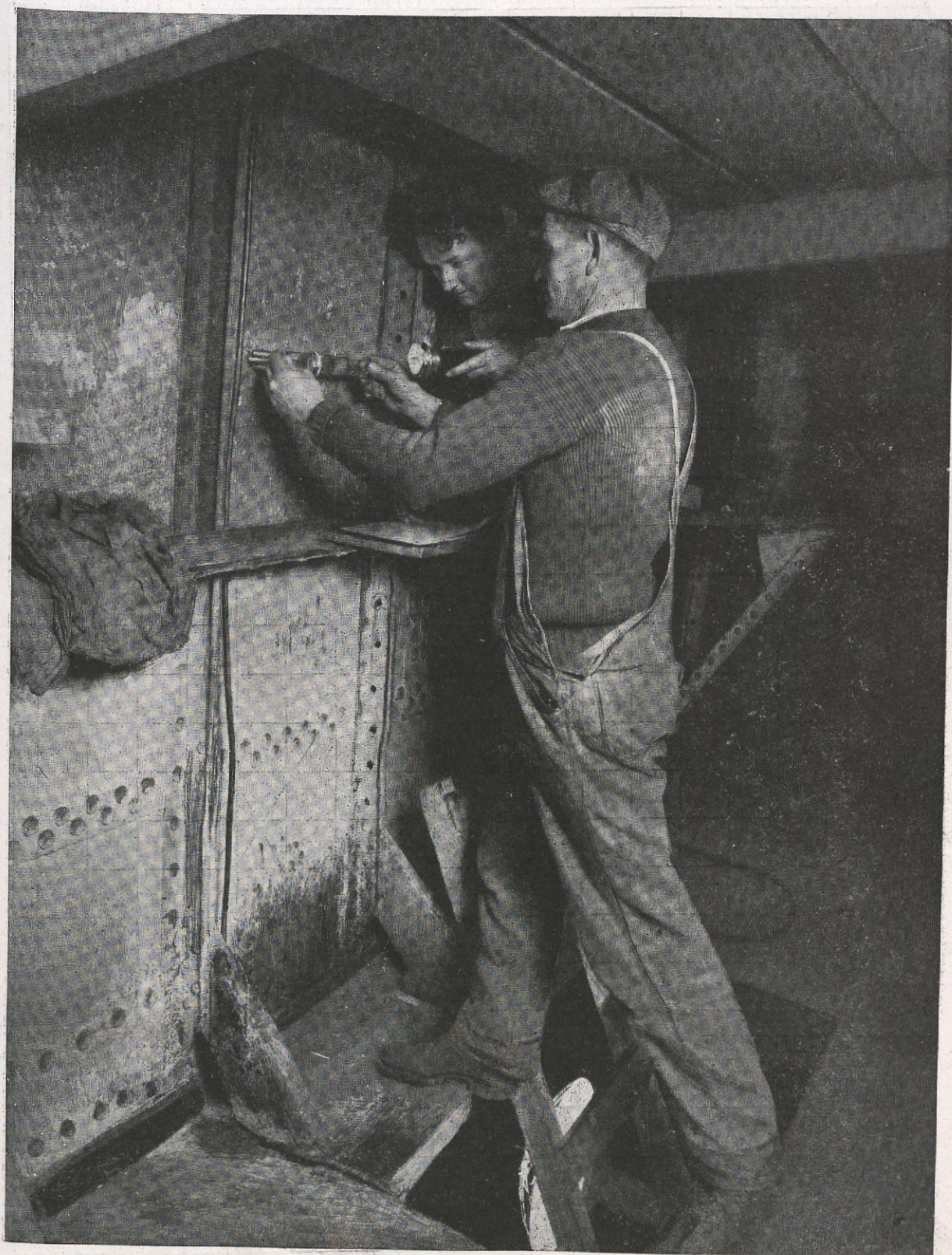
Destroyer U. S. S. «Preston».—Prueba de arrufo.—Indicando la operación de tomar las lecturas del aparato para medir la fatiga.—Astilleros de Norfolk Portsmouth VA Serie n.º 69-31 1-28-31
